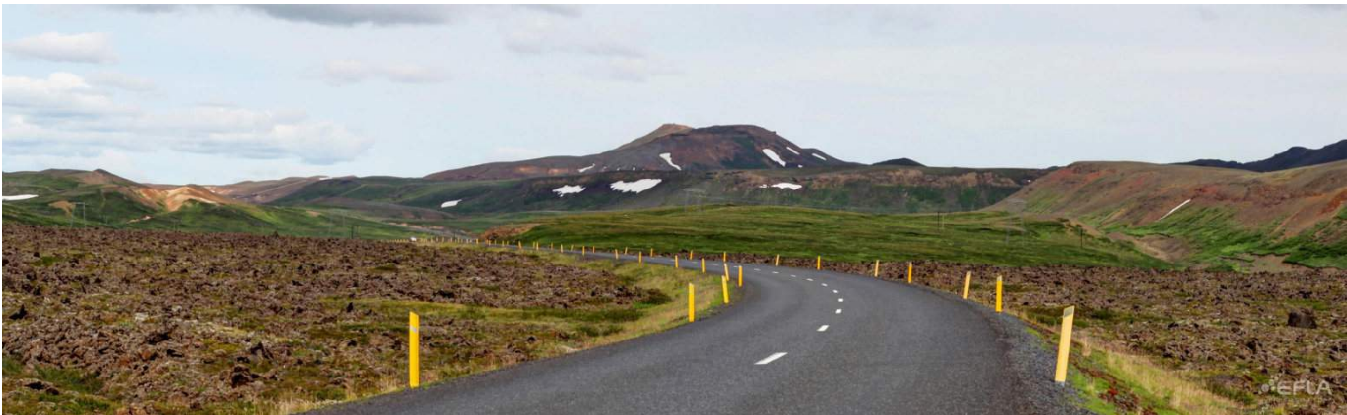
Mynd 5.4: Hlíðardalur, aðkomuvegur að Kröflu. Valkostur B2, M-stálgrindarmastur.
