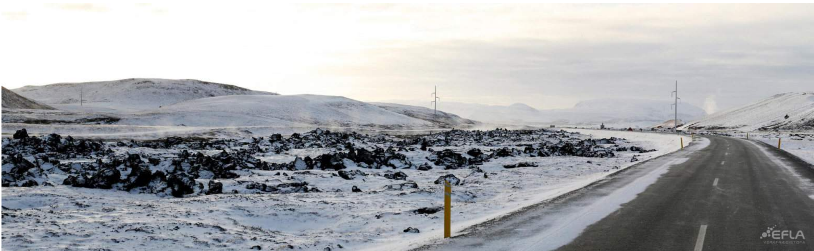
Mynd 3.8: Við Kröfluvirkjun. Valkostur D, I-mastur.
