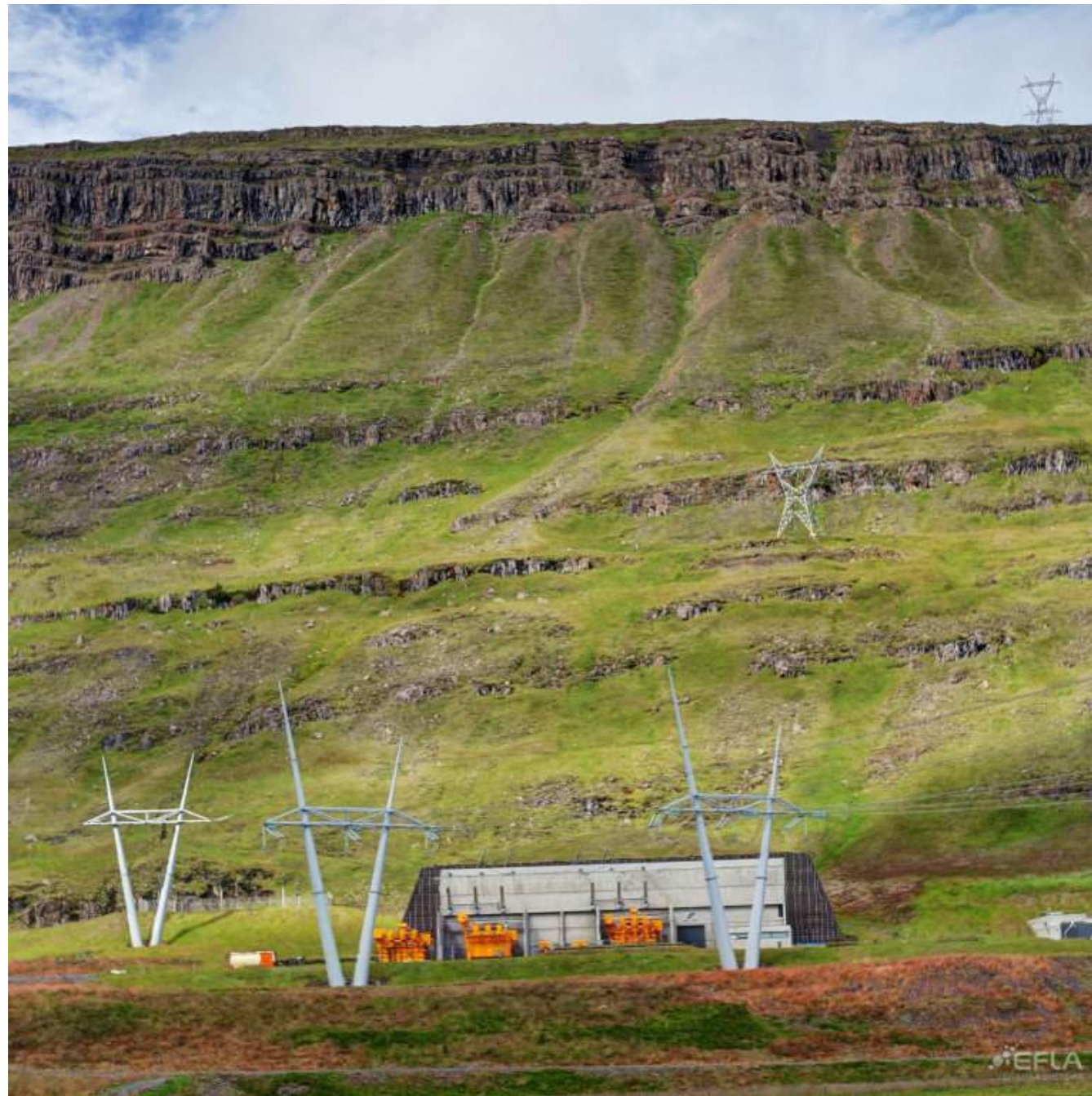
Mynd 25.1: Fljótsdalur, Fljótsdalsvirkjun. Núverandi útsýni.
