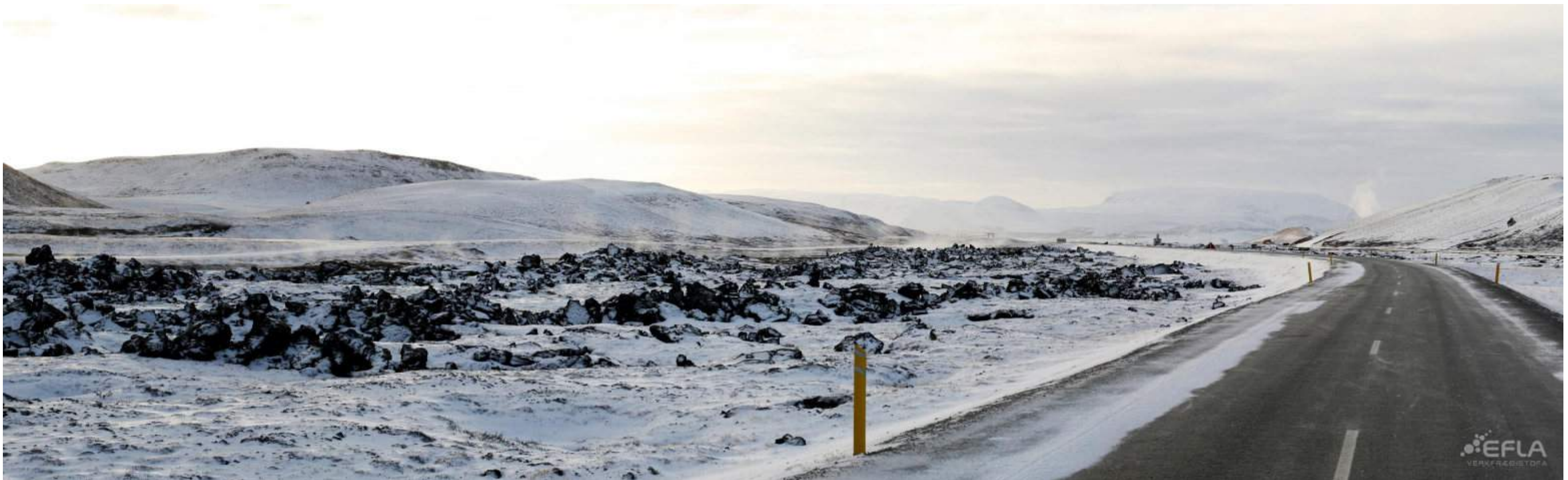
Mynd 3.4: Við Kröfluvirkjun. Valkostur B2, M-stálgrindarmastur.
