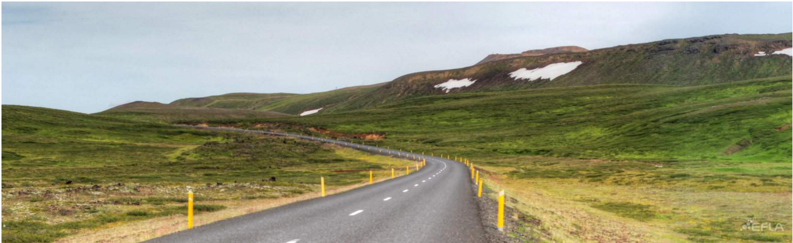
Mynd 4.1: Hlíðardalur, aðkomuvegur að Kröflu. Núverandi ástand.
