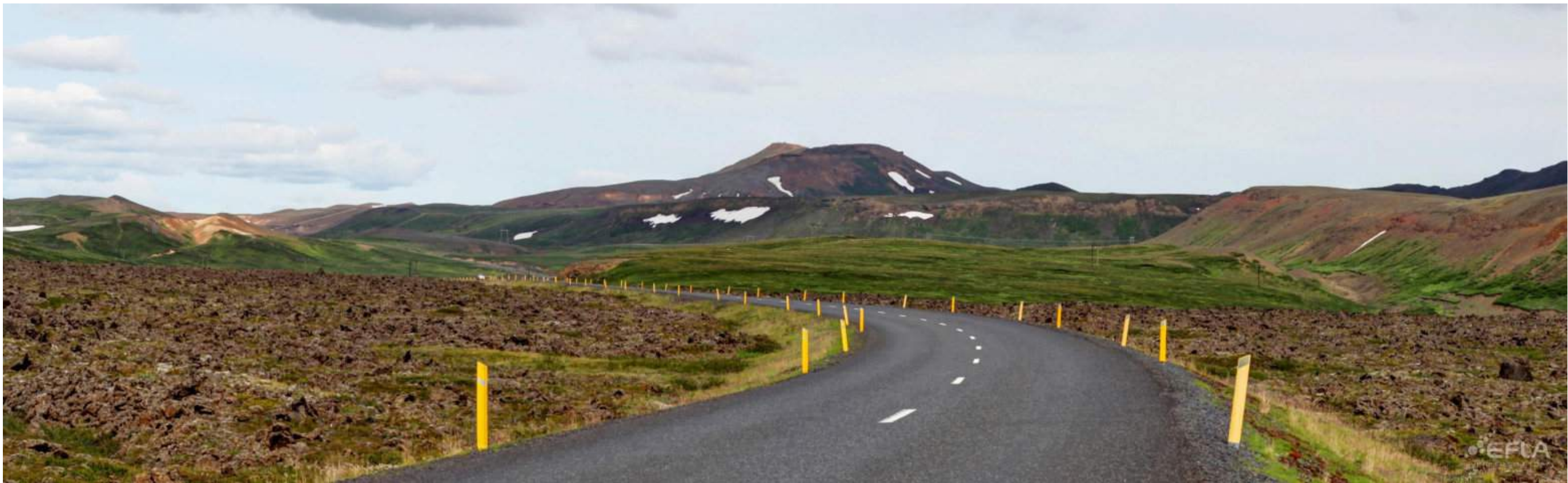
Mynd 5.3: Hlíðardalur, aðkomuvegur að Kröflu. Valkostur B1, M-stálgrindarmastur.
