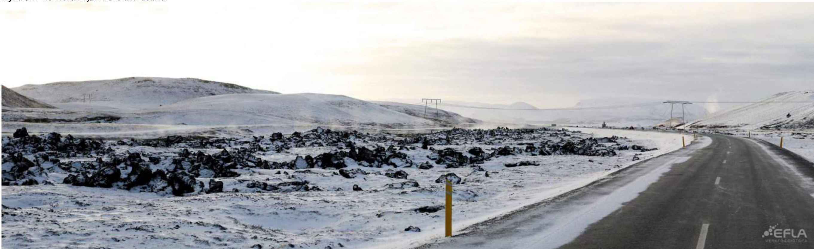
Mynd 3.2: Við Kröfluvirkjun. Aðalvalkostur, M-röramastur.
